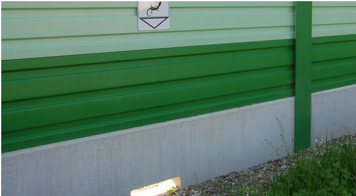
Abbildung 2: Beispiel einer Lärmschutzwand mit freigelassener Öffnung für Eidechsen als Verbundmöglichkeit von Habitaten.
