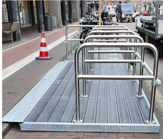
Abbildung 2: Temporäre Radabstellanlage „fietsvlonder“
