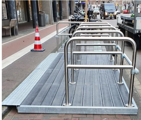
Abbildung 2: Temporäre Radabstellanlage „fietsvlonder“
