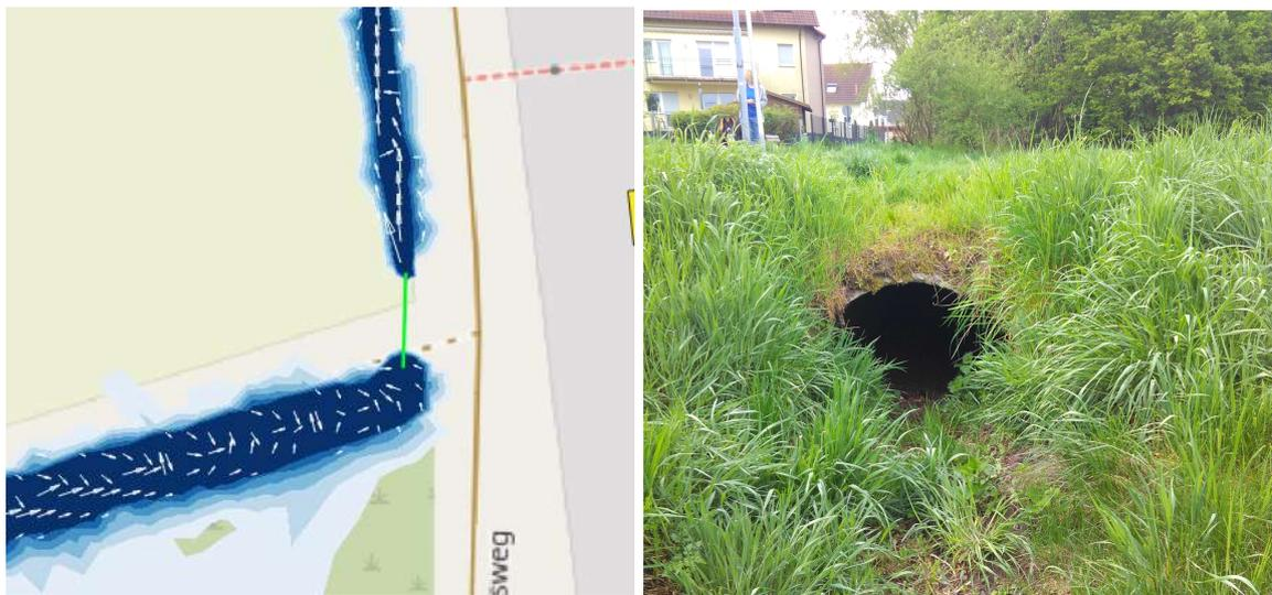
Abbildung 3: Beispielhafte Abbildung einer hydraulischen Struktur, hier Grabenverrohrung, im gekoppelten Modell (links) und Aufnahme des Durchlasses vor Ort (rechts).
